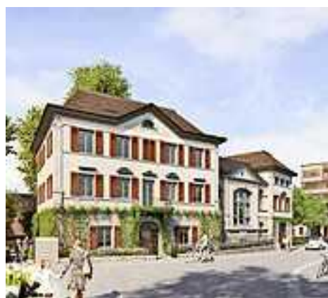
Behutsame Sanierung der Villa Iwan und Franziska Rosenthal.
